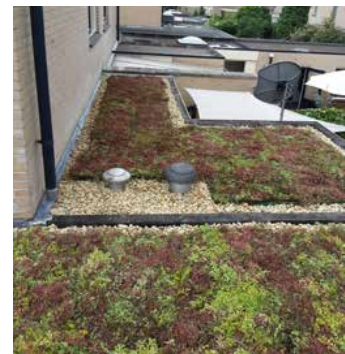
Groene daken als oase tussen traditionele dakvlakken
